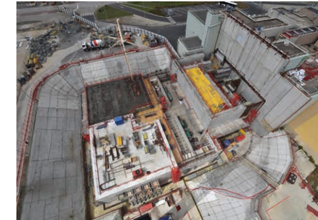
♥ Extension de l'atelier d'entreposage des coques compactées d'Orano Cycle, La Hague
