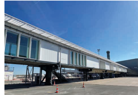
♥ Passerelle de liaison entre les satellites 1 et 7 du terminal 1 de l'aéroport Paris-Charles de Gaulle, Roissy-en-France
