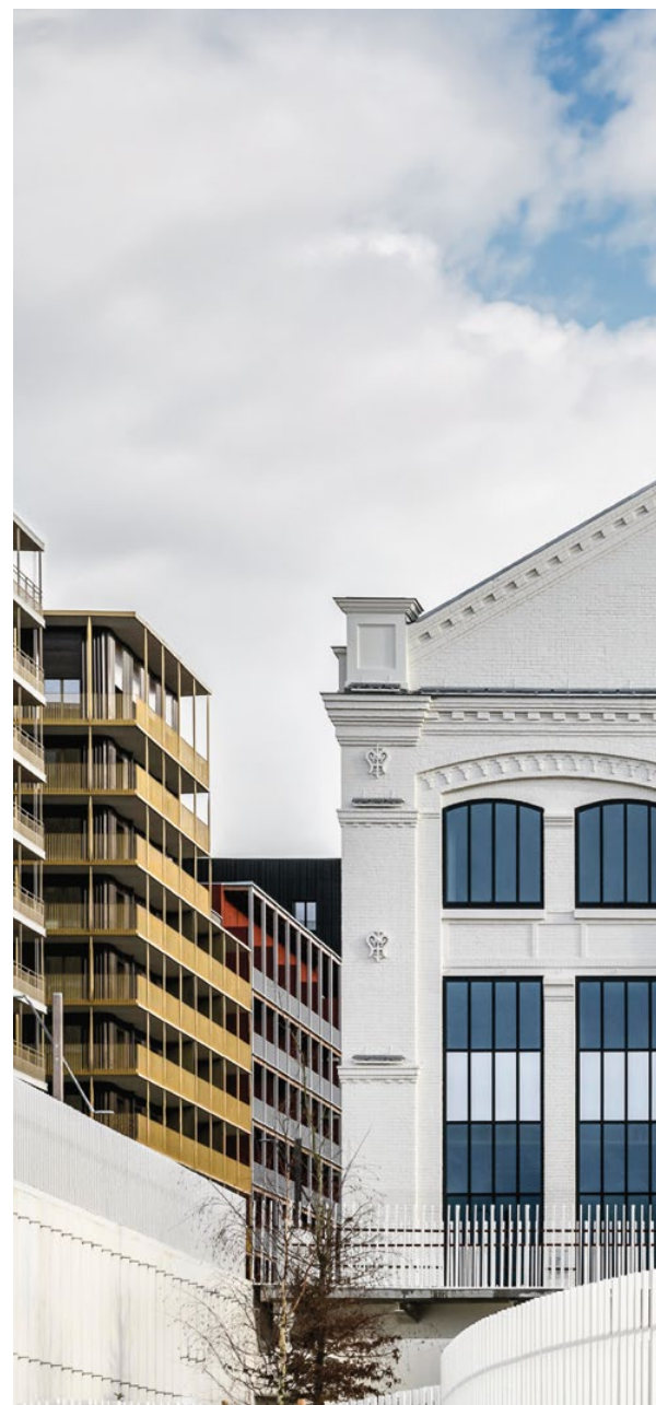
↑ Symbole d'Universeine, le Village des athlètes a été inauguré le 29 février 2024 à Saint-Denis. La requalification de cette friche industrielle, portée par VINCI Immobilier, a combiné réhabilitation menée par Dumez Île-de-France et construction neuve pilotée par Bateg associés, entre autres, à Arbonis, Structures Geotechnics et Structures Île-de-France, avec trois mots d'ordre : écoconception, qualité d'usage et réversibilité.
