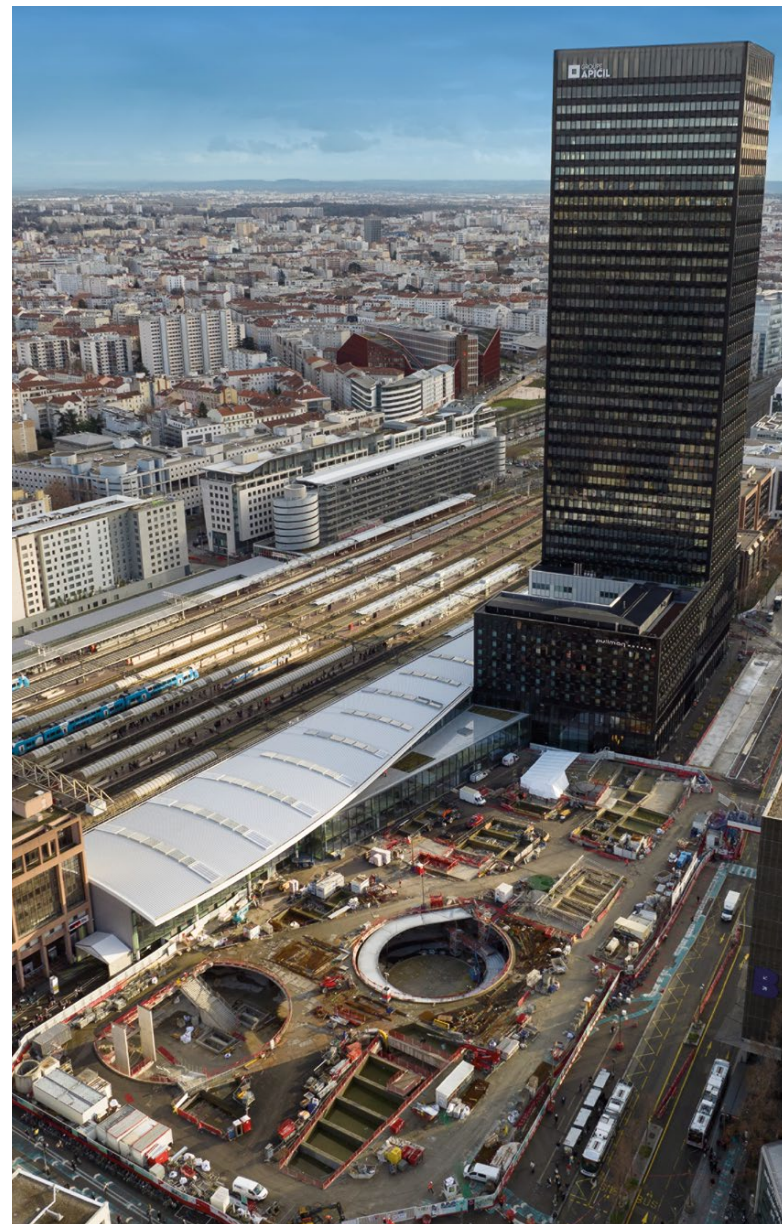
↑ Développée par VINCI Immobilier et livrée en novembre 2023, la tour To-Lyon est désormais la deuxième plus haute du quartier de Lyon Part-Dieu. Campenon Bernard Centre-Est et Citinéa, associés à GTM Sud avec le soutien de Steeleom, Structures Île-de-France et Campenon Bernard Topographie, ont réalisé un ensemble de bureaux et un hôtel quatre étoiles auxquels s'ajoutent des commerces, le nouveau hall de la gare, le parking et la place Béraudier.
