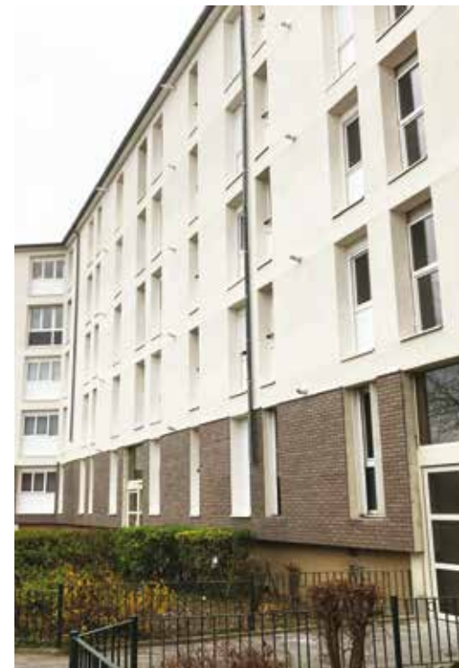
Ensemble résidentiel de 105 logements, Reims
