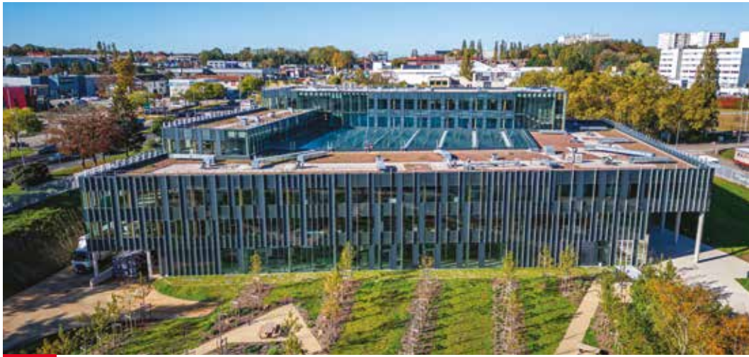
Immeuble de bureaux, Laxou
