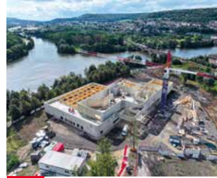
Pôle aquatique intercommunal, Bassin de Pompey
