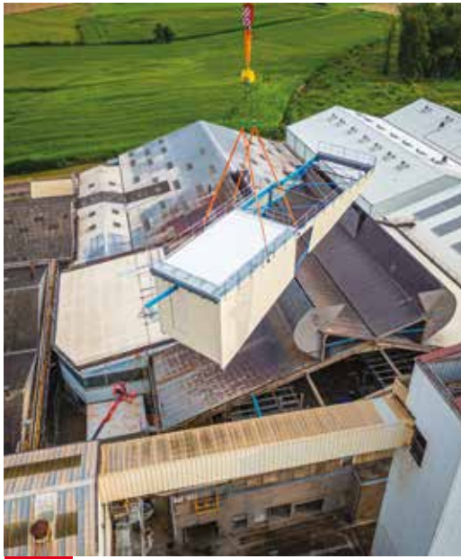
Adaptation d'un bâtiment de production, Gironcourt-sur-Vraine
