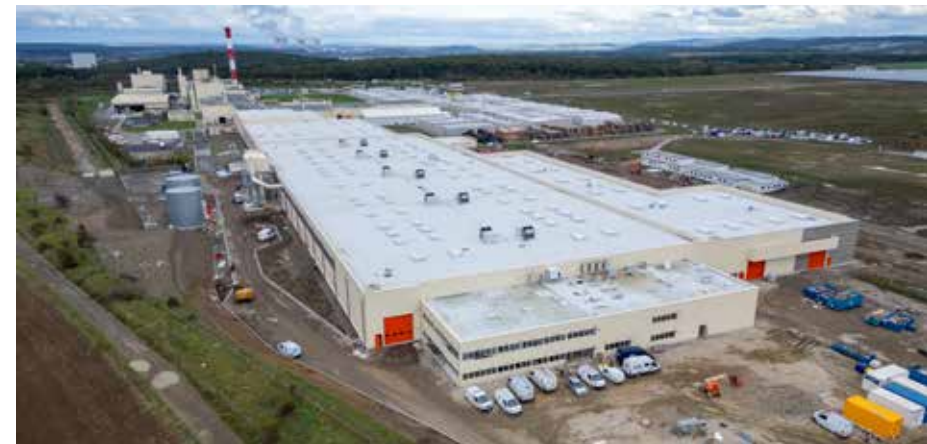
Agrandissement d'une unité de production, Illange
