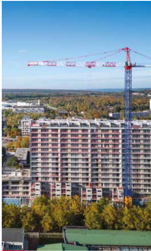
Immeubles de logements, quartier du Haut-du-Lièvre, Nancy
