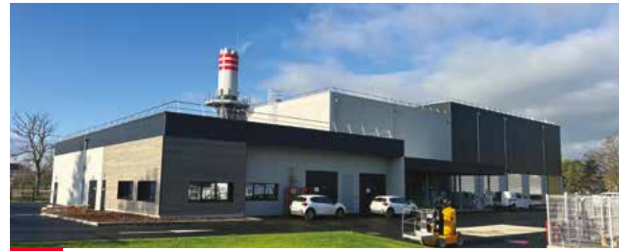
Chaufferie biomasse, camp bâti, Mourmelon-le-Grand
