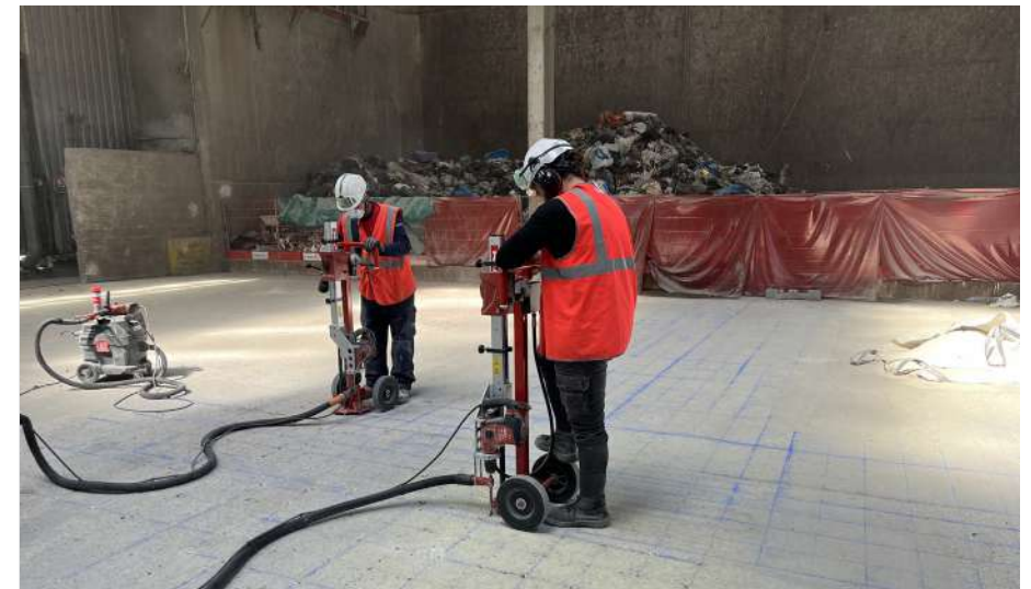
Renforcement d'une dalle de déchargement d'une usine d'incinération, Schweighouse-sur-Moder
